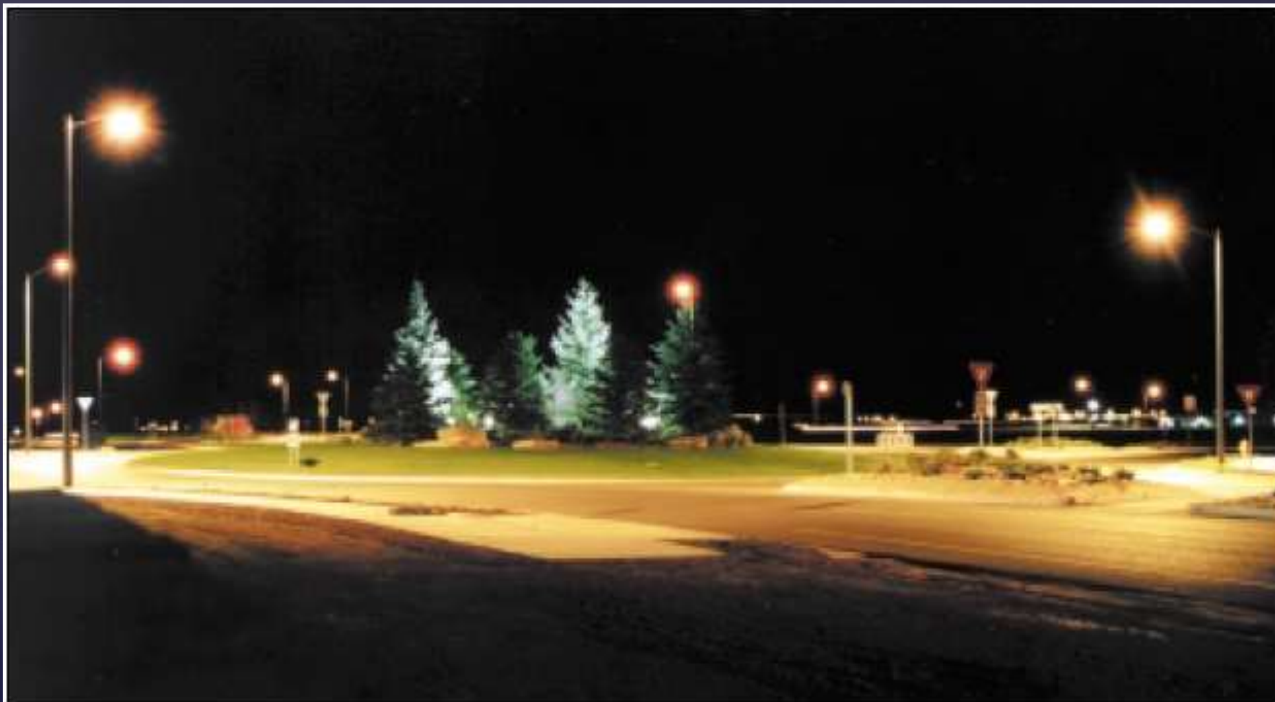
Iluminación de rotonda
