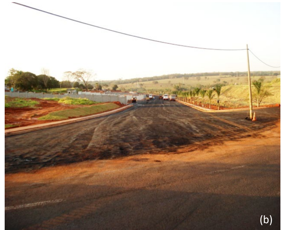
(b) Base em solo após a aplicação do EMULPEN.
