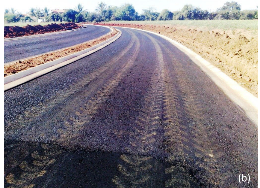
(b) Base de brita graduada 48 horas após a aplicação do produto.
