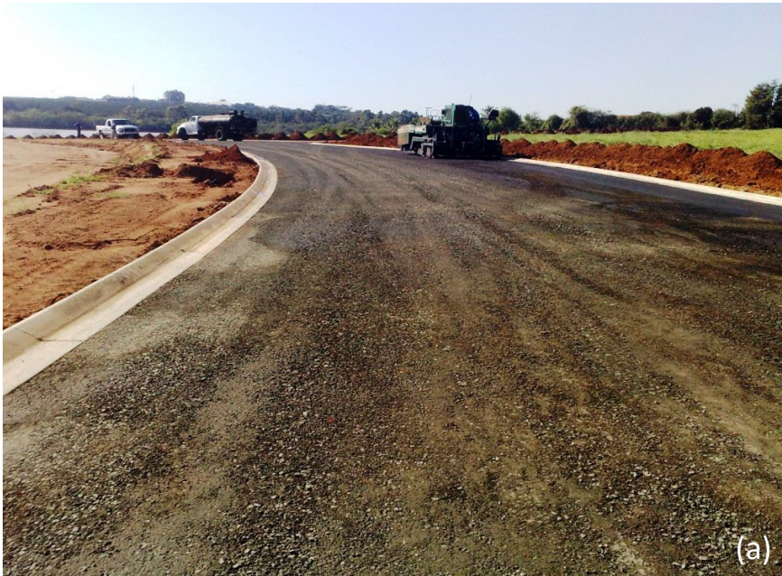
(a) Base de brita graduada antes da aplicação.
