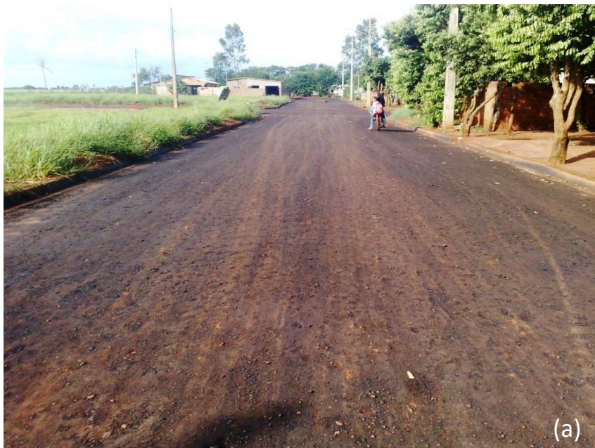
(a) Base em solo 5 dias após a aplicação.
