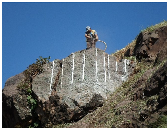
Figura 4. Demolición de bloque en voladizo con cal hidráulica expansiva.
