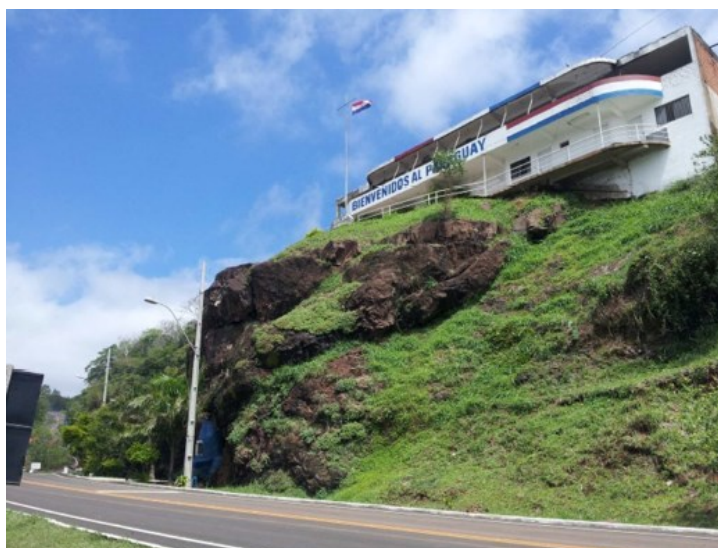
Figura 2. Talud de roca en Puerto Presidente Franco antes de ser estabilizado.
