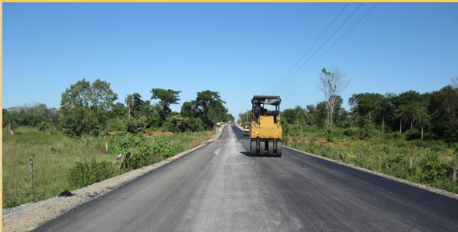
Vista general de la carpeta de concreto asfáltico con caliza en zona de San Alfredo
