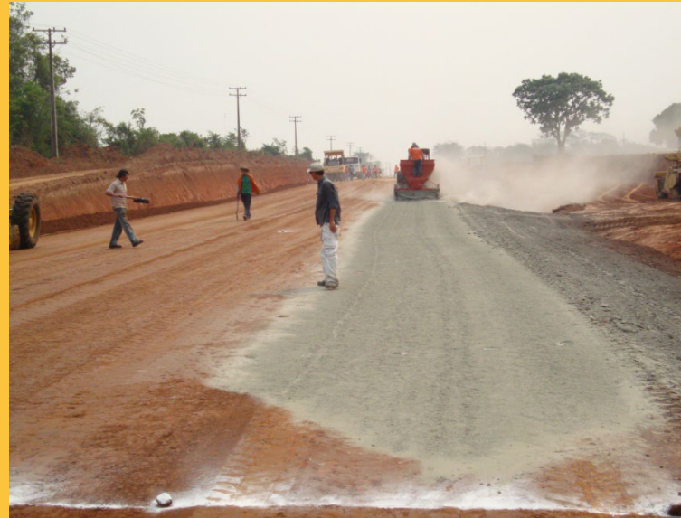
Tramos de Prueba en Terreno
