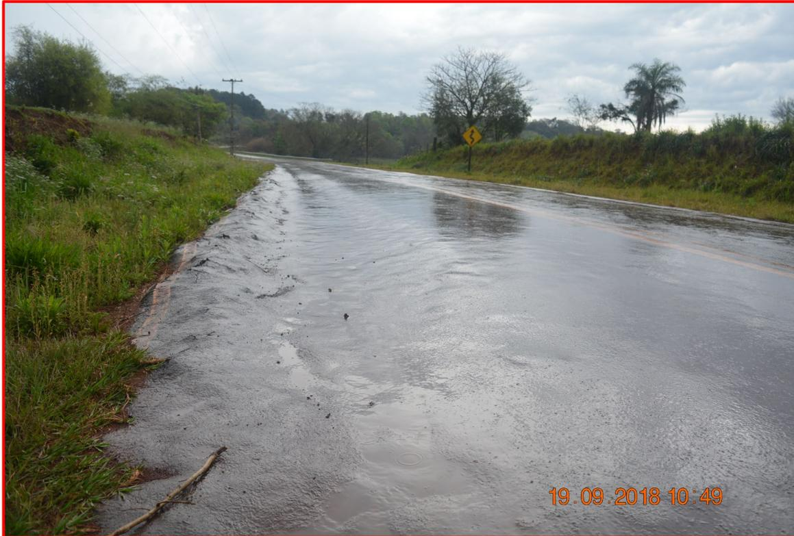
Carpeta asfáltica sobre empedrado con ahuellamientos
