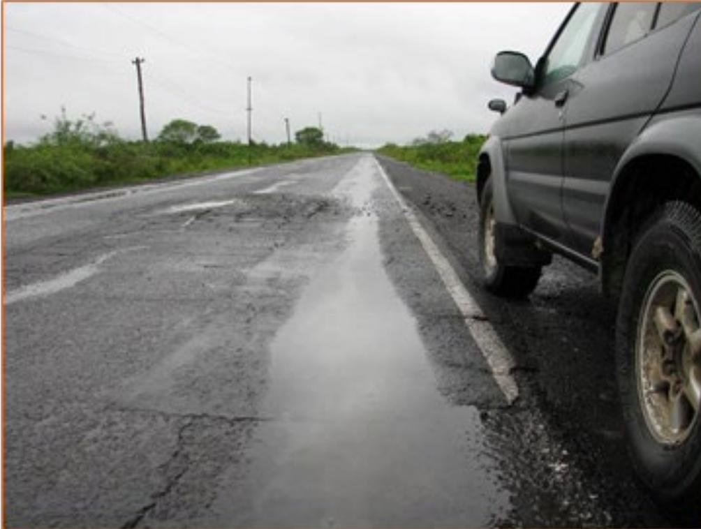
**Ahuellamiento:** El ahuellamiento en los pavimentos flexibles es debido a la deformación permanente de la subrasante a lo largo de la huella.
