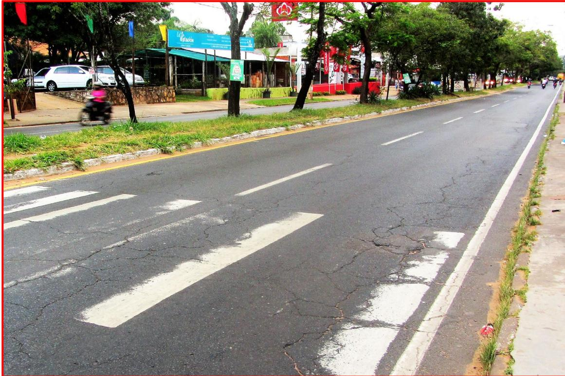
Carpeta asfáltica sobre empedrado con fisuras
