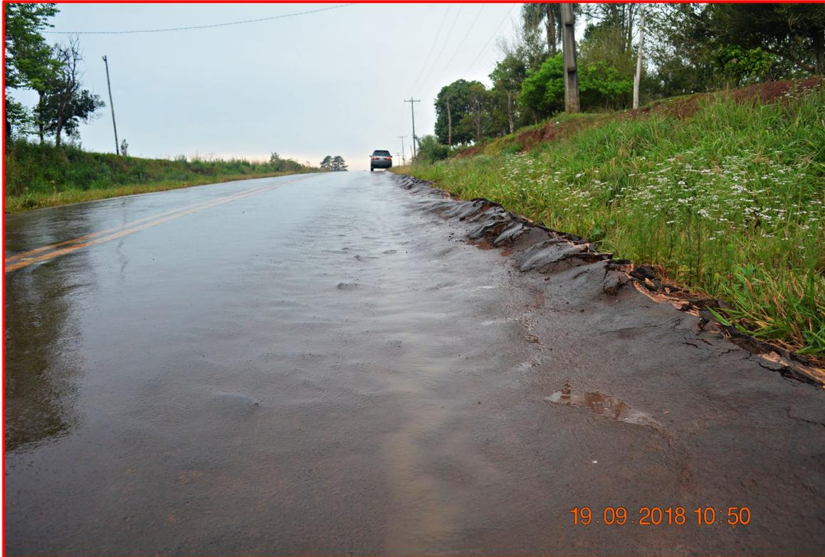
Carpeta asfáltica sobre empedrado con ahuellamientos
