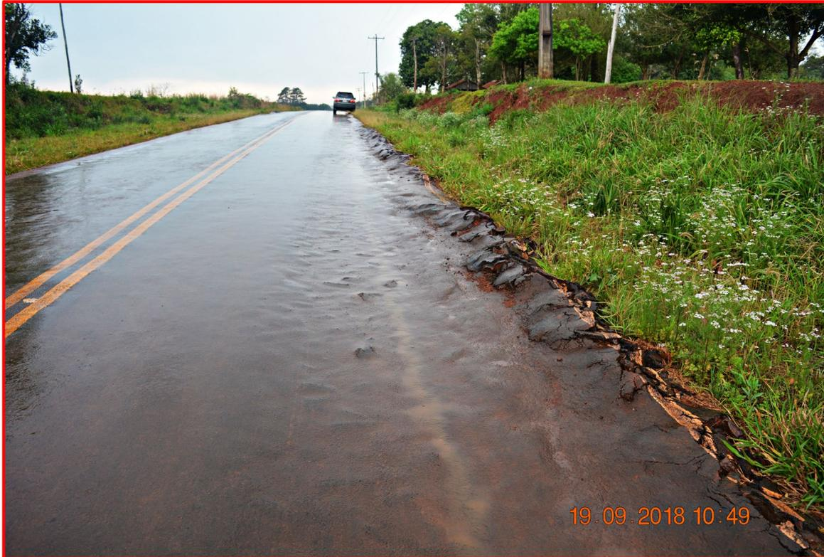
Carpeta asfáltica sobre empedrado con ahuellamientos
