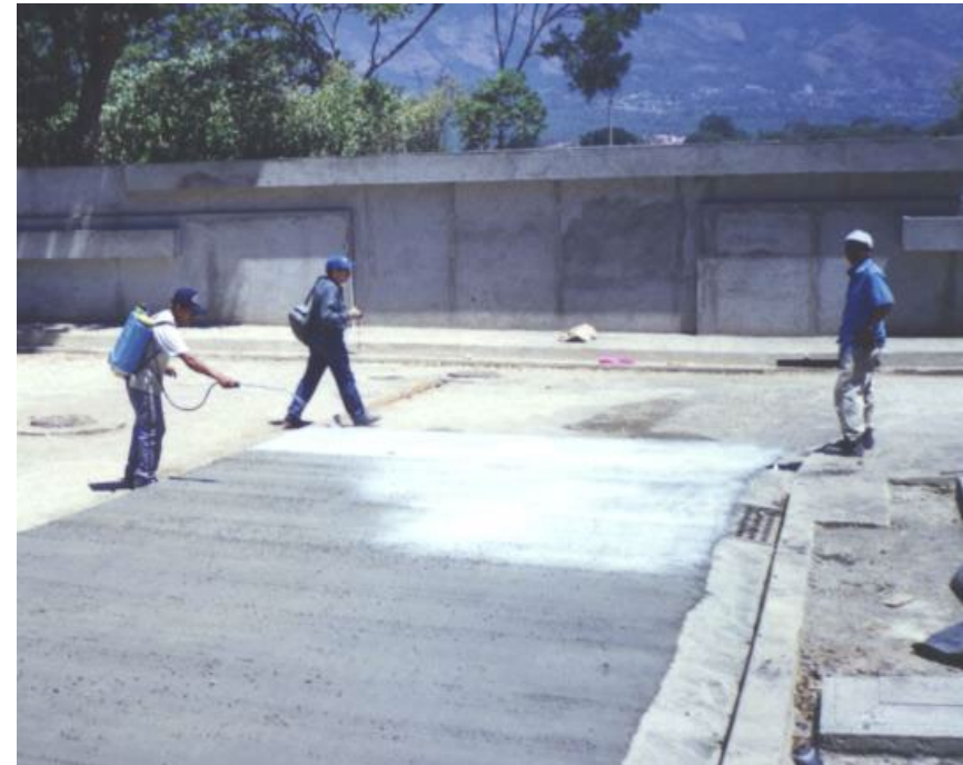
Equipo manual para curado. Caso de pavimentación de vías residenciales
