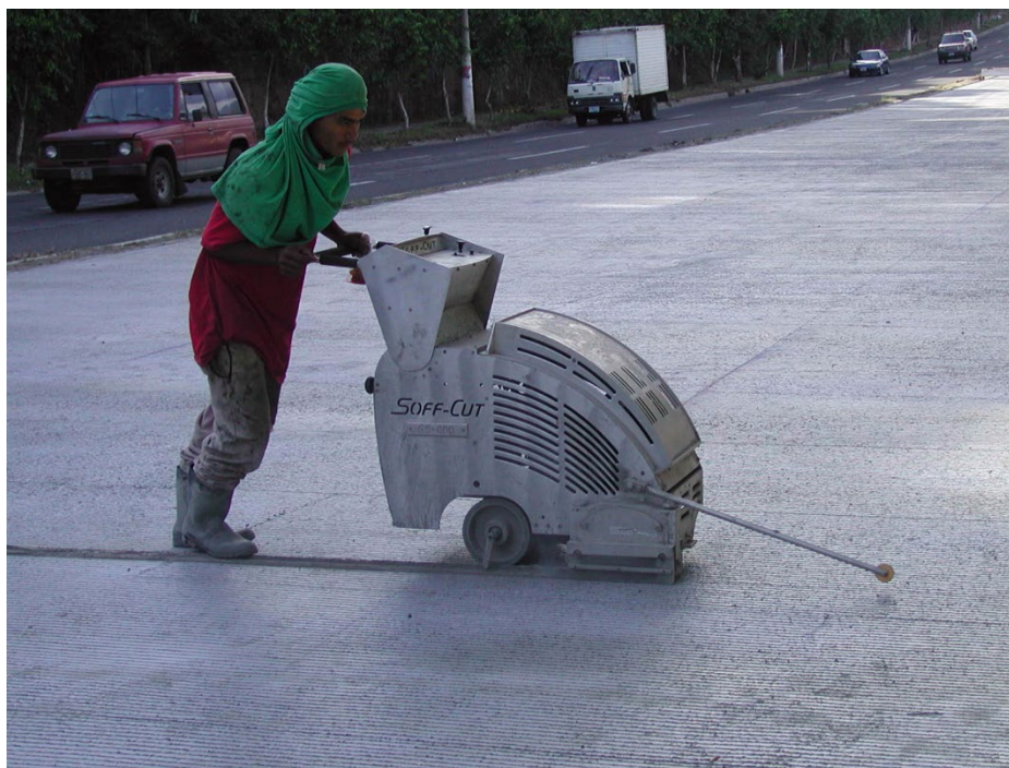
Equipo con tecnología reciente para corte en verde, aplicado en proyectos de gran envergadura
