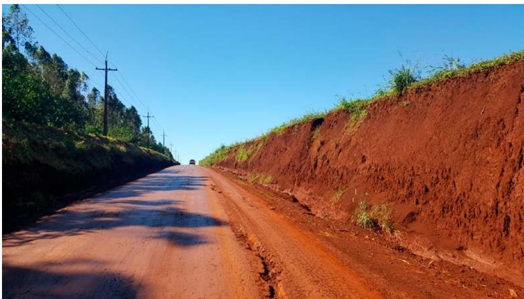
Figura 3.4_3. Camino sin Drenaje Lateral - Paraguay
