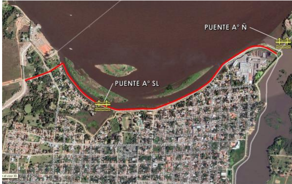
PUENTES SOBRE EL A° ÑEEMBUCÚ Y A° SAN LORENZO
