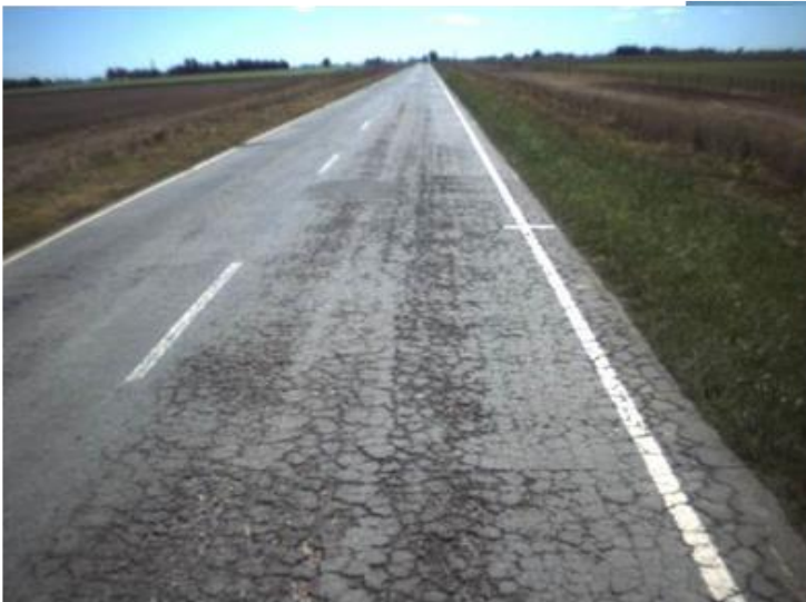
Desempeño en servicio de membranas "SAMI" de Arena Asfalto, retardadoras de reflexión de fisuras
