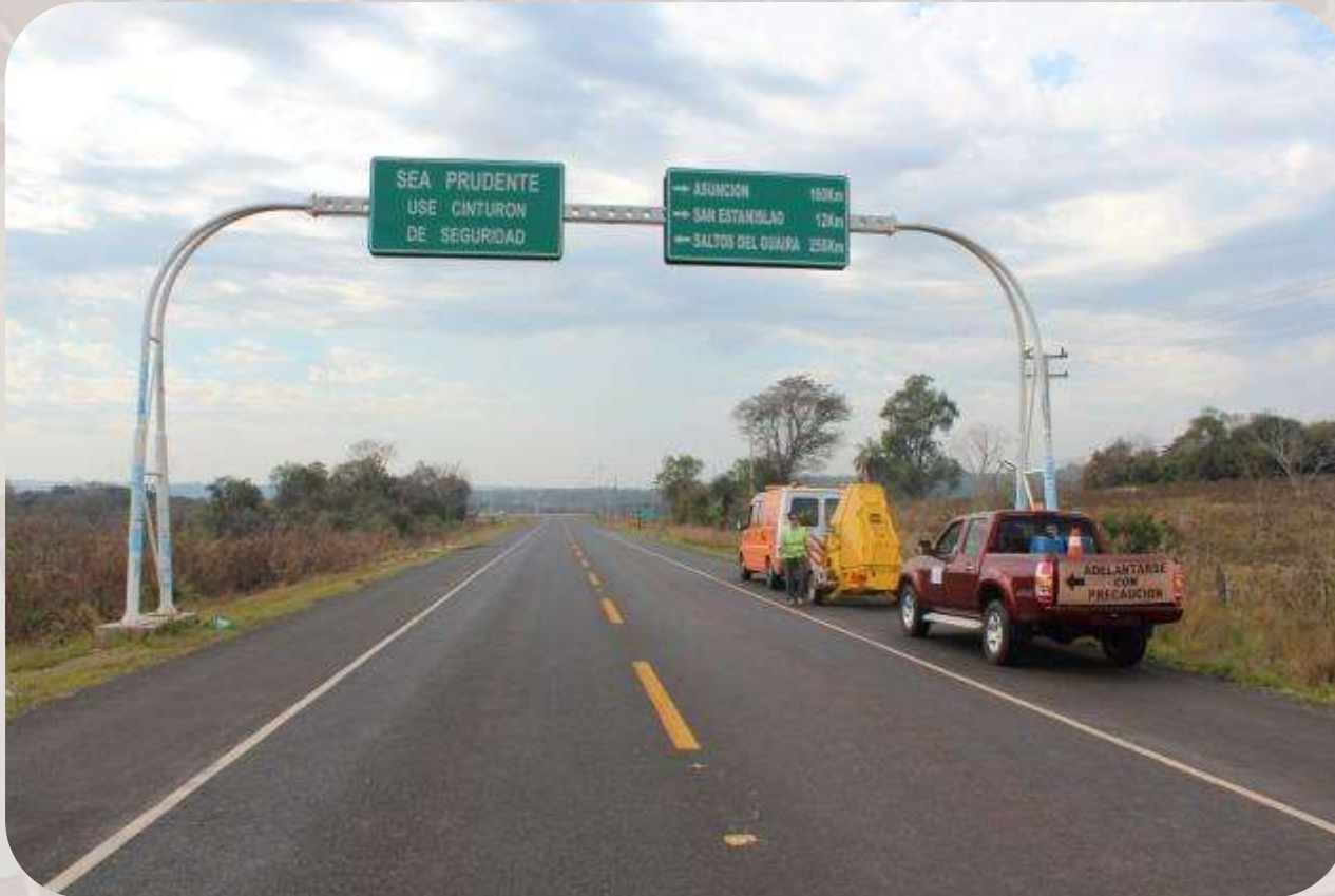
Vista del tramo en estudio. Equipo FWD con vehículo de apoyo
