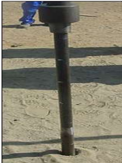
Marcado de Longitud a Penetrar
