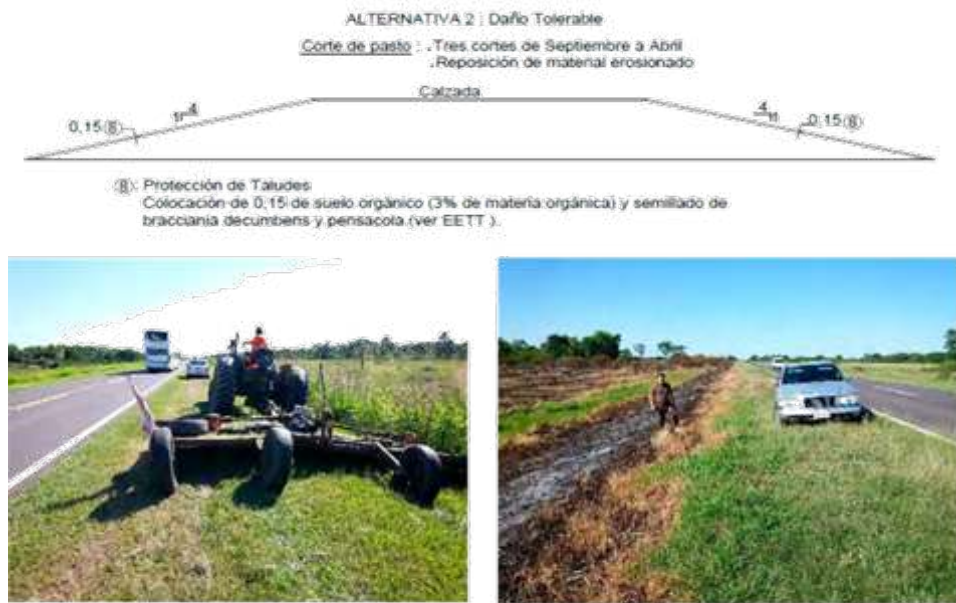
Figura 6.1_215. CASO 2. Daño Tolerable.
